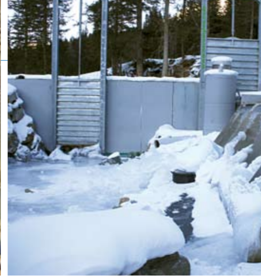
Einlaufbauwerk mit Fertigteilstaumauer und Restwasserabgabe bei minus 20 Grad
